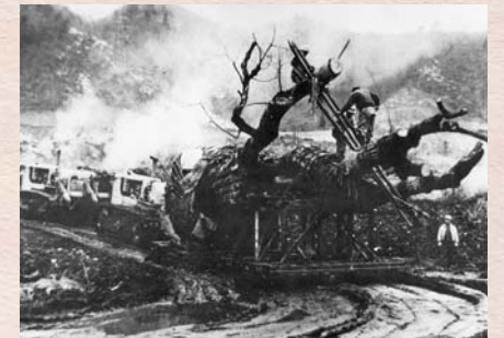
ブルドーザーで引きずられ、坂道の上ってゆく莊川桜。その無残な姿は、まるで原型をとどめていませんでした。
