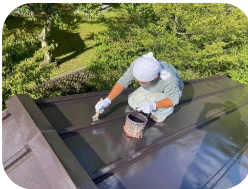
(屋根の塗装作業現場にて)
