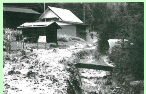
土石流が流れ出た新田洞林道（中畑地区）
